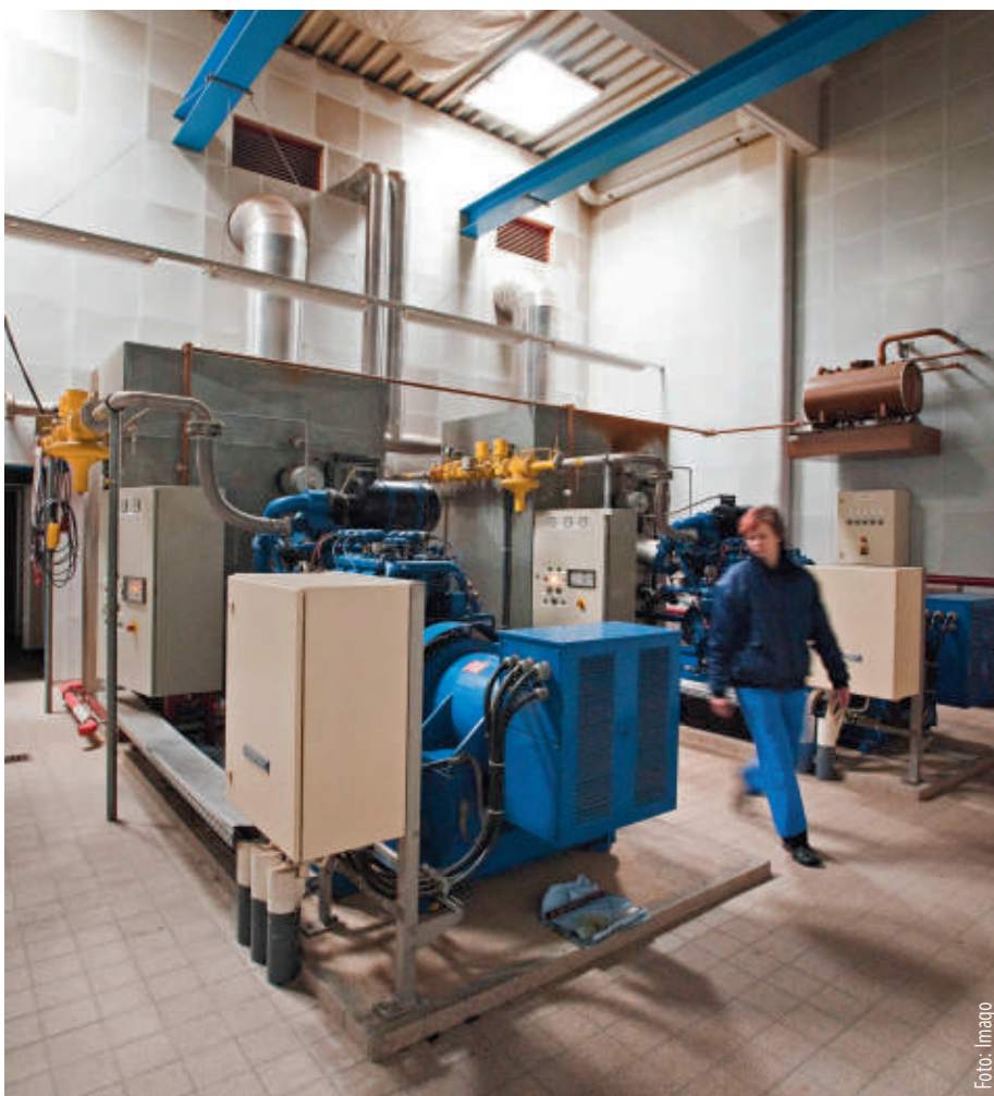
Ein Blockheizkraftwerk (BHKW) kann Biogas mittels Kraft-Wärme-Kopplung in Strom umwandeln.
